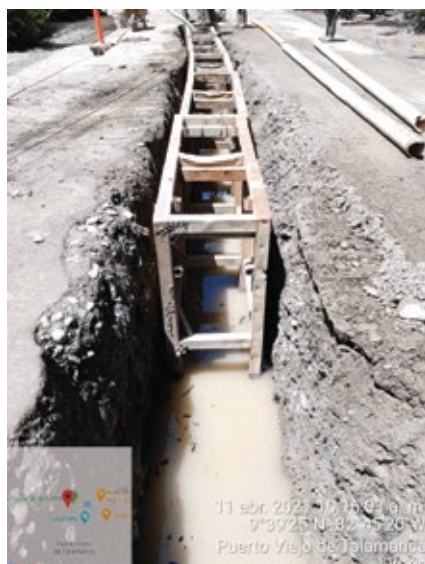
Sistema de ademado colocado en las excavaciones
