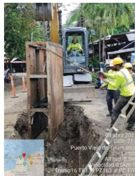
Uso de cuerdas para maniobrar los ademes cuando se colocan en la zanja
